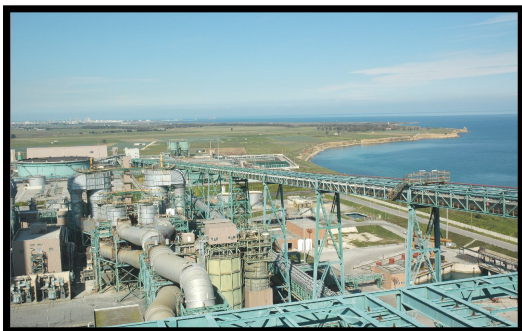
Impianti di ambientalizzazione
